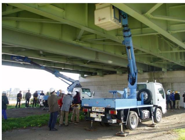
現地学習会は、今年度「とちの実橋」を点検した「(株)ワイ・シー・イー」の協力で実施。現場では3班に分かれ、①主に橋脚を中心に橋全体の点検、②高所作業車による桁下の点検、③はしごを利用した桁端部の点検を順番に体験しました。寒空の中、経験豊富な点検員の解説を、真剣な眼差しで聞いていました。
