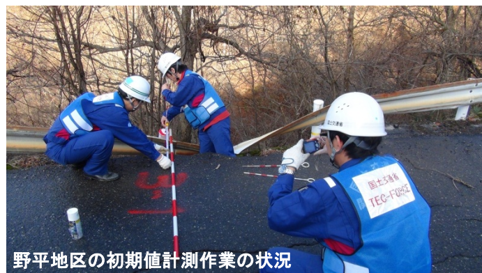
青鬼地区の調査状況
