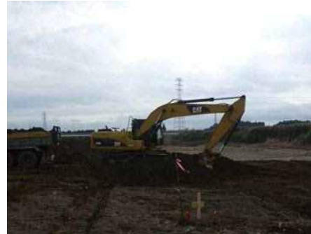
バックホウ(掘削・法面整形)
