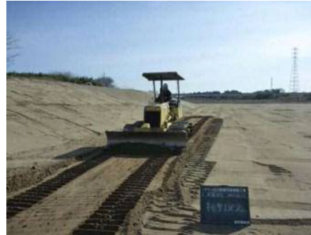
ブルドーザ(敷均し)
