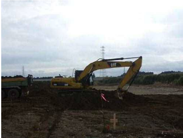
バックホウ(掘削)
