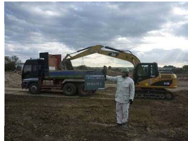
写真⑧:ダンプトラック積み込み状況
