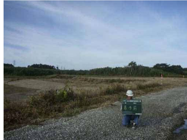
写真②:着工前
