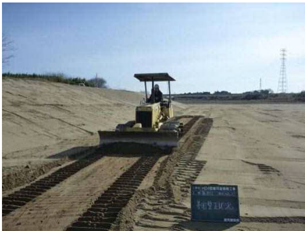
ブルドーザ(敷均し)
