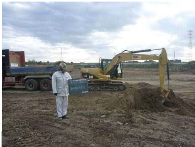
写真⑦:掘削状況
