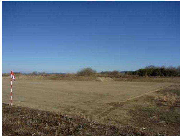
写真③:完了後
