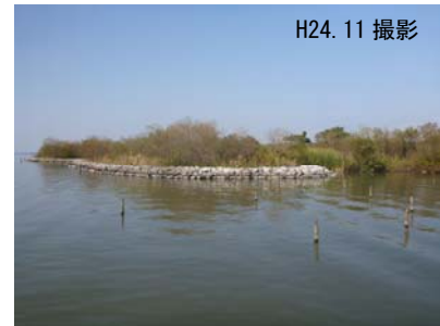
図 6.8-5 島堤の現地写真
