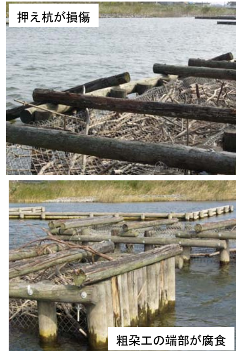
図 6.4-20 粗朶消波工の腐食・損傷状況
