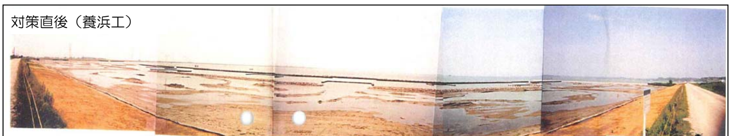
図 6.4-4 景観写真 対策後（評価検討会現地見学会 H15.11 より）
