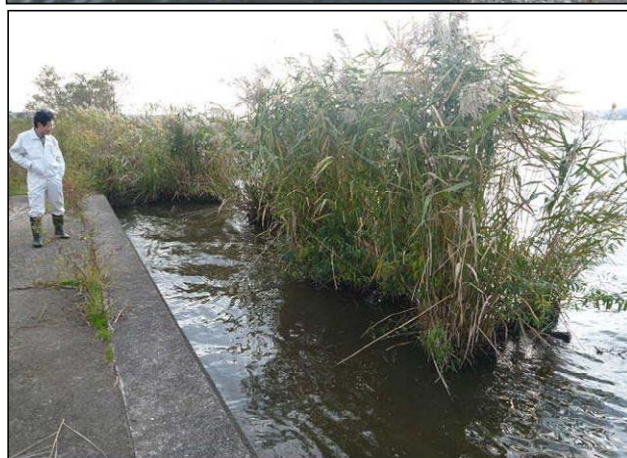
・対策工として捨砂工が行われているが、当初の施工高 (Y.P.+1.1m) の捨砂は見られない。 ・波浪、湖流の影響などによりヨシの生育基盤は侵食されていると考えられる。これにより、ヨシは株化している。 ・水深は、約20cmである。
