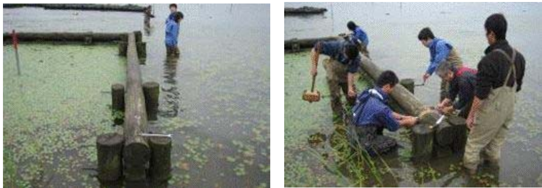
図 6.7-42 杭柵工の試験的な撤去（出典：東京大学 西廣 HP）
