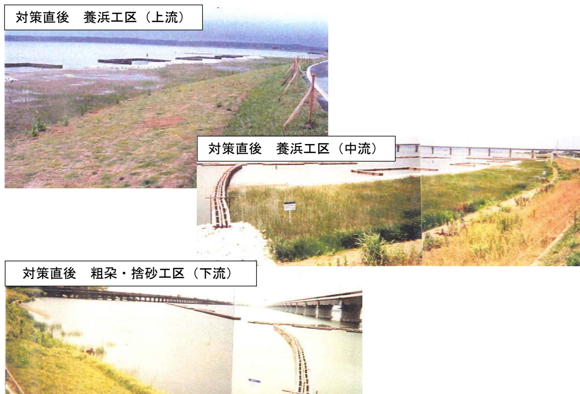
図 6.7-4 景観写真 対策後（評価検討会現地見学資料 H15.11 より）
