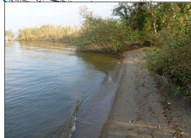
・沖合には、粗朶消波工が設置されている。 ・湖岸の一部には、砂浜が形成されている場所が見られる。 ・底質は砂であり、固く締まった状態である。
