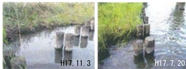
中央右：H15 年板全部撤去
