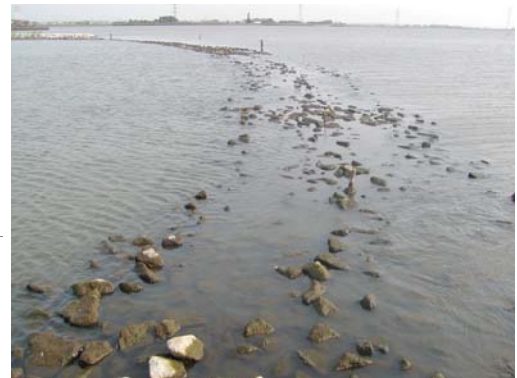
H16. 7. 13 人工リーフ（永山地区） 写真撮影した日は水位が低下 （湖心水位 Y. P. +0.95m）した状態であった。
