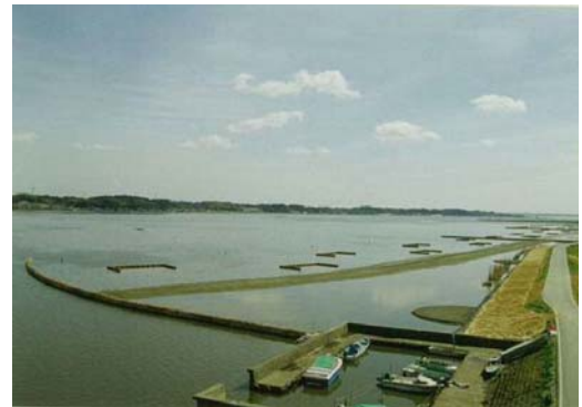
H15. 施工直後 砂堤工（石川地区）
