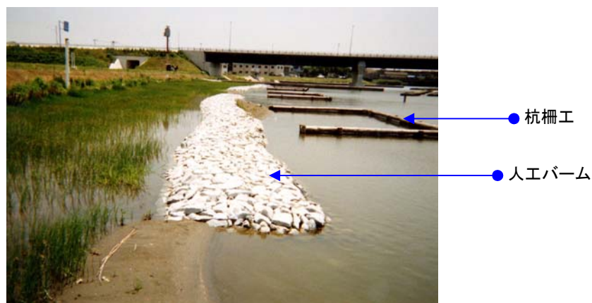
H15. 施工直後（大船津地区）
