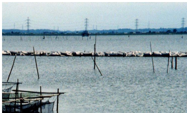
H15. 施工直後 異型ブロック式消波工 (麻生地区)
