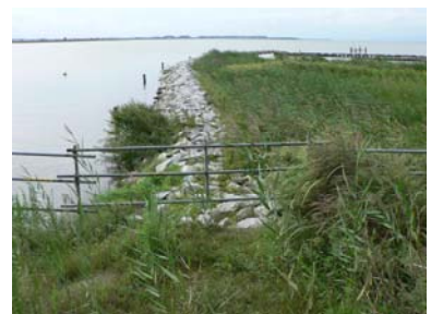
H18. 9. 16 突堤構造は保持されている
