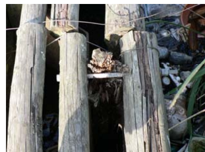
H18.9.15 矢板式突堤の上部の木杭が腐食した（石川地区）
