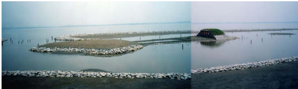
H15. 施工直後 島堤工（根田地区）
