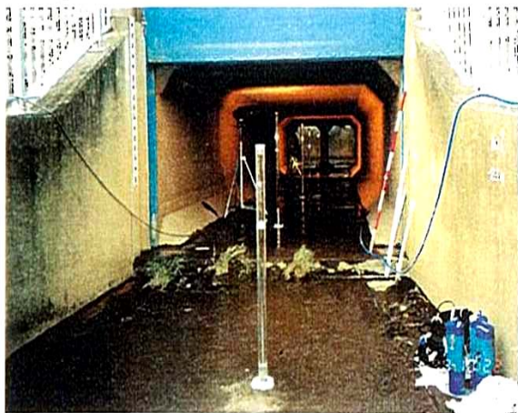
写真-19 アクリル製試験管の立ち上げ
