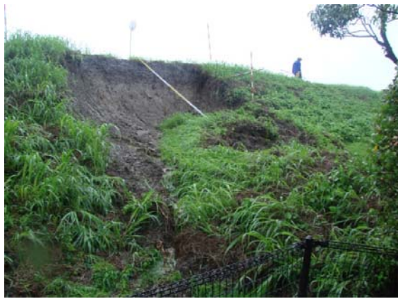
図 2.2 出水後の法崩れの状況
