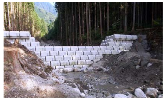
コンクリートブロック積み砂防堰堤のイメージ
