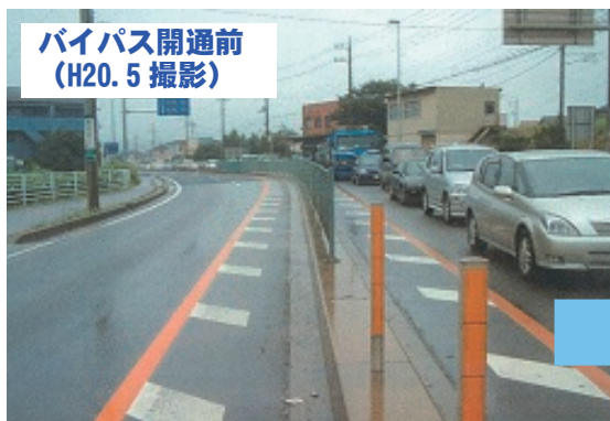
写真1 阿久津交差点での渋滞発生状況
