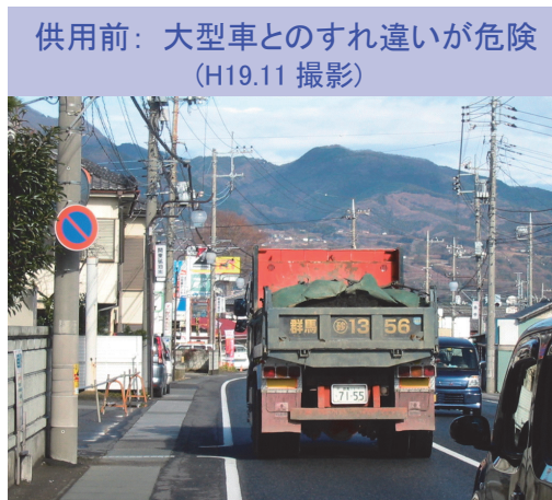
写真3 バイパス開通前の国道17号現道
