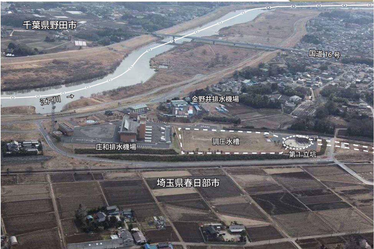
庄和排水機場 逆アングル
