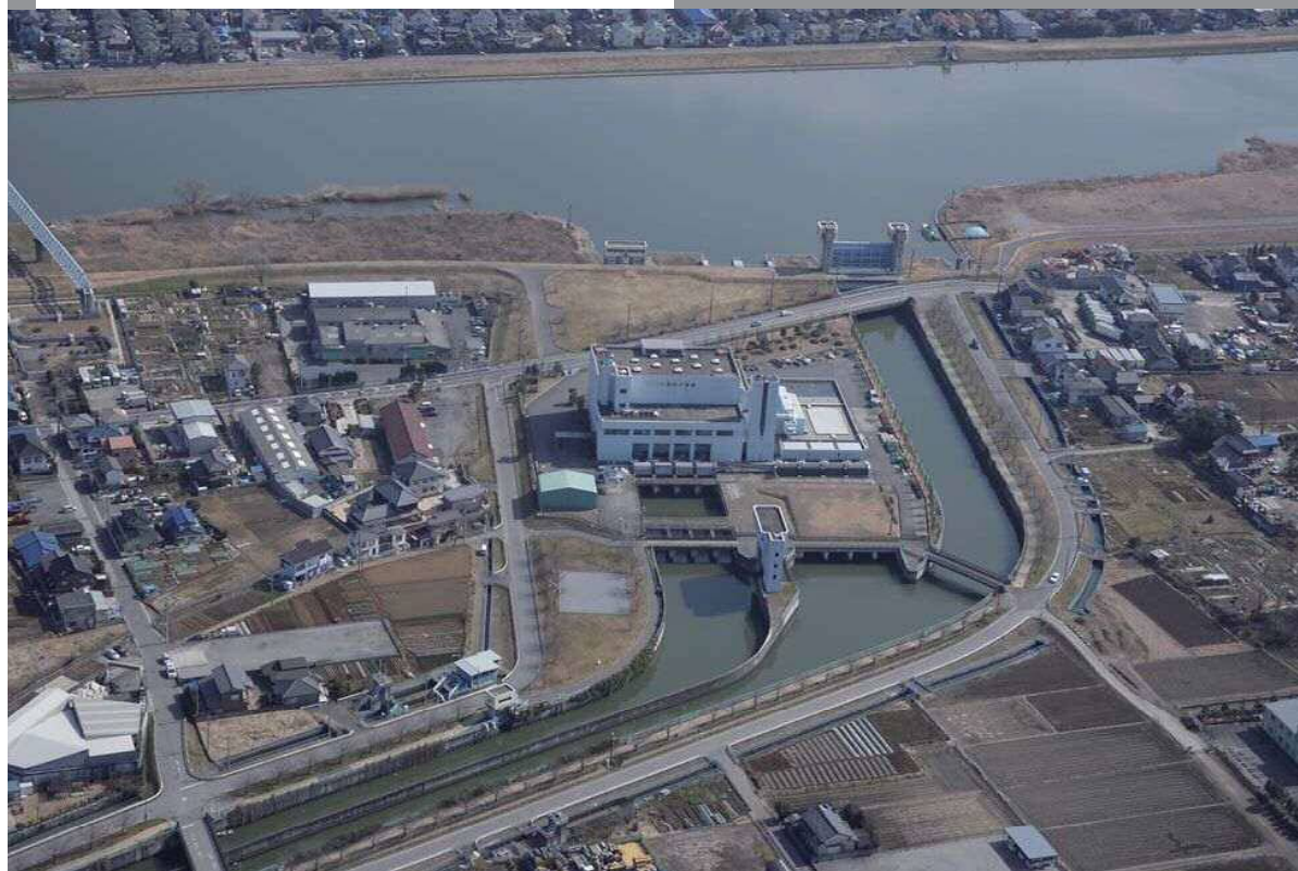
綾瀬川放水路
