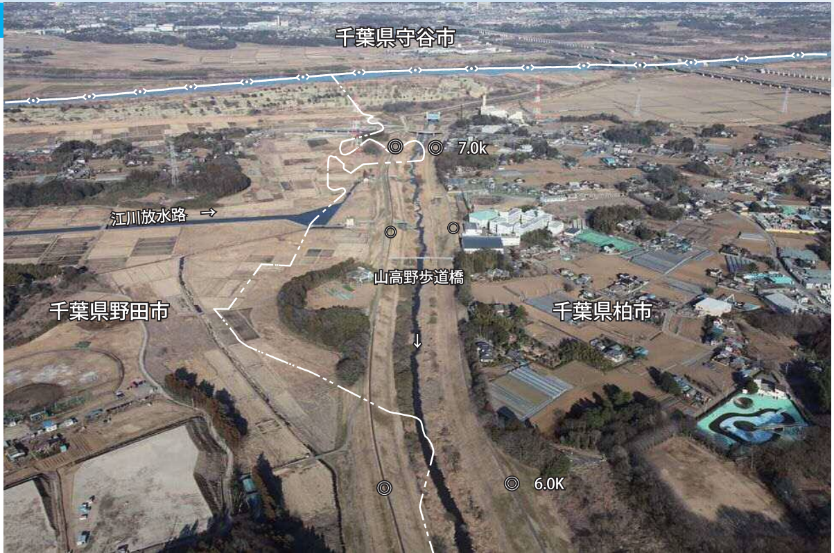
▲中川上流排水機場・・・排水量 50m 3 /s
