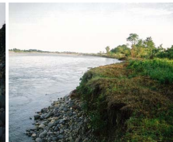
95k右岸付近の河岸侵食状況
