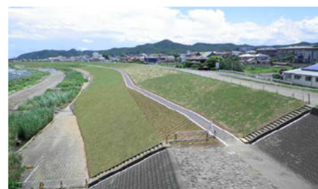
桐生大橋右岸下流部盛土工事完成状況
