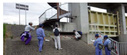
堤防点検の実施状況
