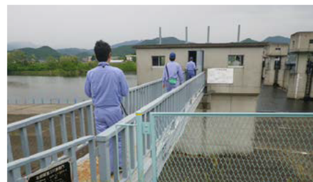
堰の履行検査実施状況
