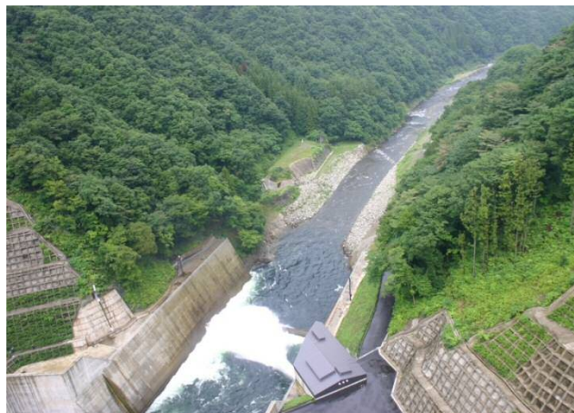
湯西川ダム放流状況(8月21日撮影)
