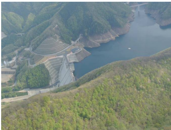
湯西川ダム全景(5月14日撮影)
