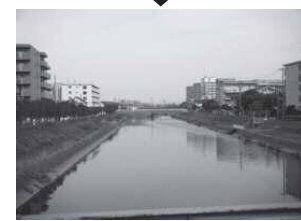
けやき橋から望んだ坂川（上：改修前、下：現在）同じ場所です。
