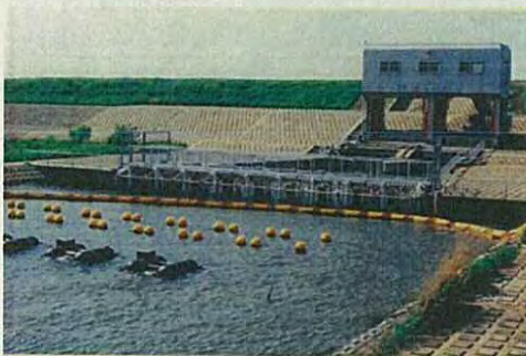
c) 利根樋管
