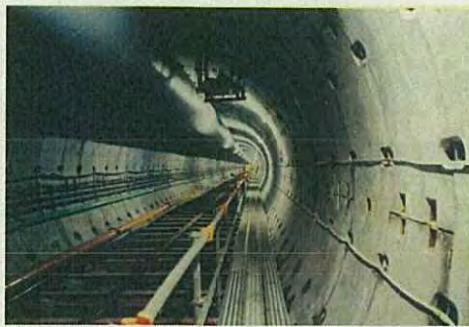
a) 利根導水路
