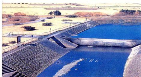
野川浄化施設
