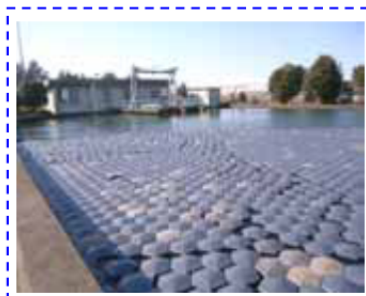
出典：正六角形ポリエチレン製のフロートを使った遮光設備（北総支部用水） 環境報告書2008 独立法人水資源機構
