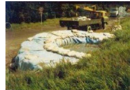
千葉県松戸市漏水状況 (S57)
