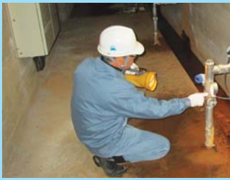
ダム堤体の点検 (外観点検)
