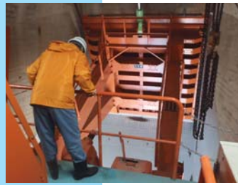
ゲートの点検 (クレストゲート)
