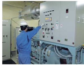
電気通信設備の点検 (予備発電機)
