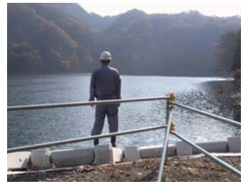
貯水池の点検 (湖面巡視)
