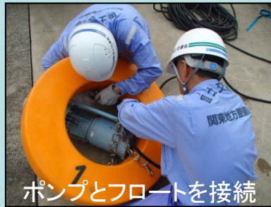
この排水ポンプ車1台で必要機材の運搬～排水運転まで可能
