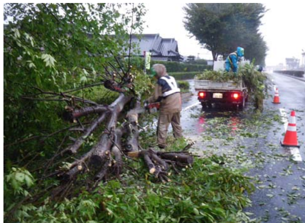
施工状況(倒木撤去)
