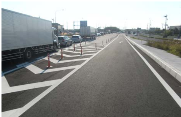
完成(右折レーン)
