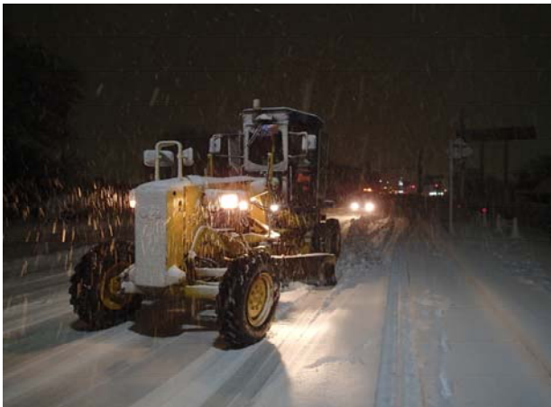
施工状況(道路除雪)
