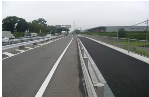
完成(張出歩道)
