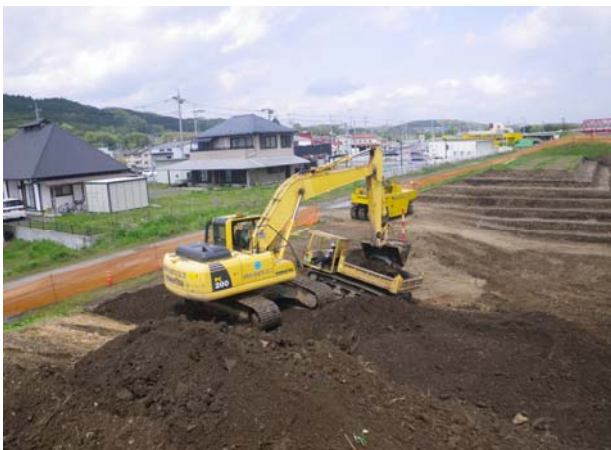
施工状況(築堤盛土)
