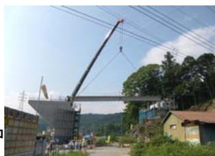
上空に高圧電線がある中クレーン架設
