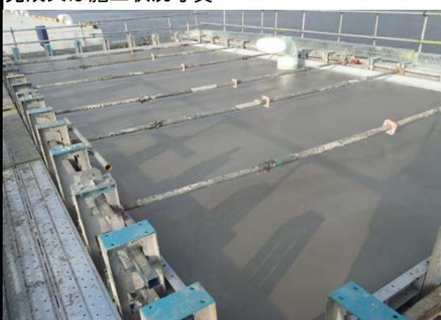
写真1; 岸壁上部コンクリート打設完了
