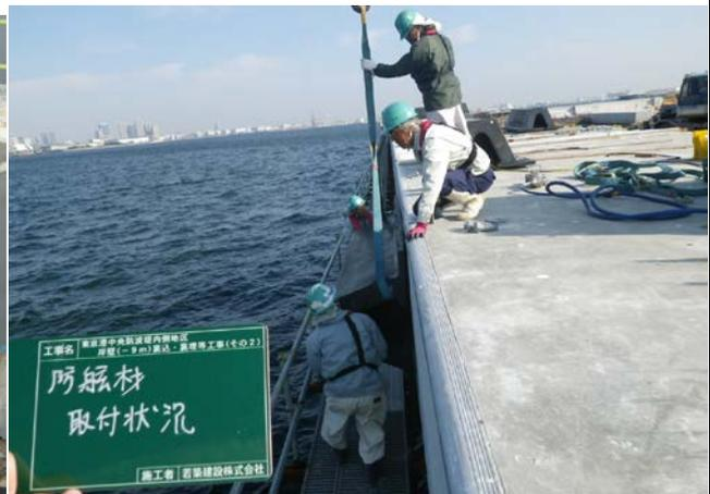
写真2; 岸壁前面の防舷材取り付け状況
