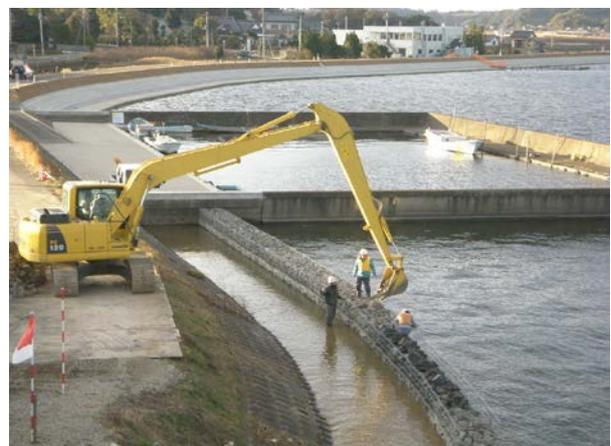
◆施工状況(堤防補修工及び根固め工)
