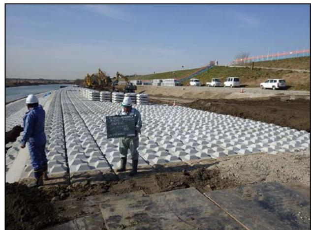
大型連結コンクリート据付状況
