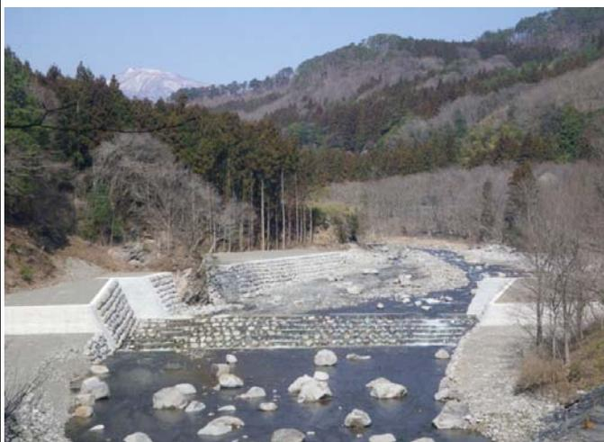
完成(床固工、石積護岸工)
