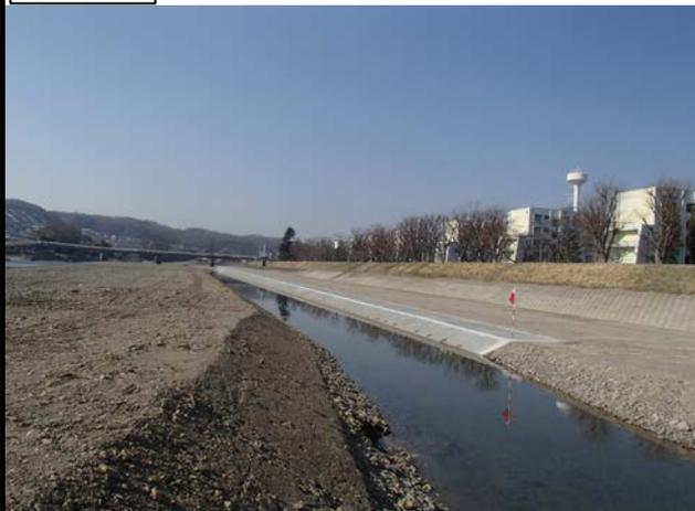
施工中(滝合排水樋管取り付け護岸設置)
