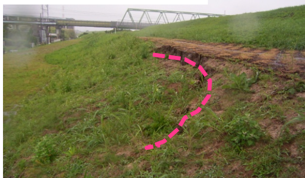
被災状況 6月7日16:00頃
