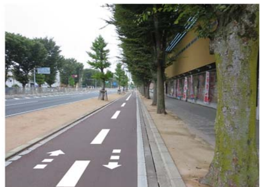
写真-6 路面標示イメージ及び防草処理
