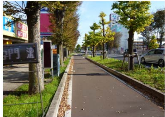
写真-5 自転車道整備状況（モデル区間）
