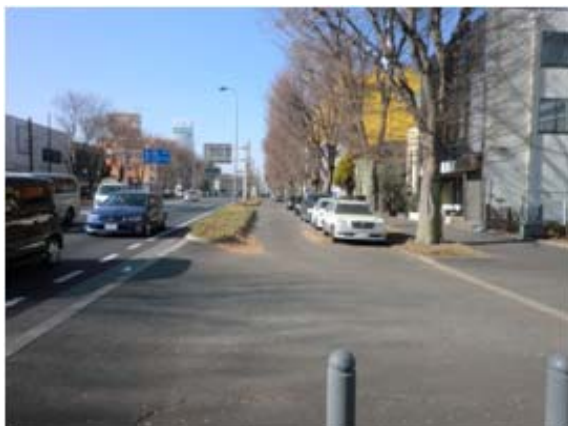
写真-1 側道部の駐停車両状況
