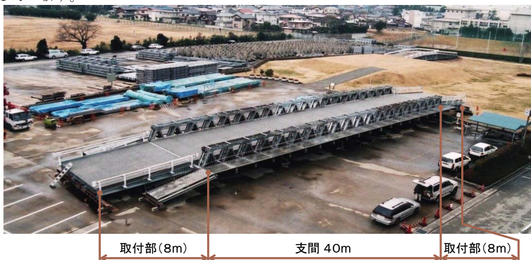
写真－1 応急組立橋架設状況
