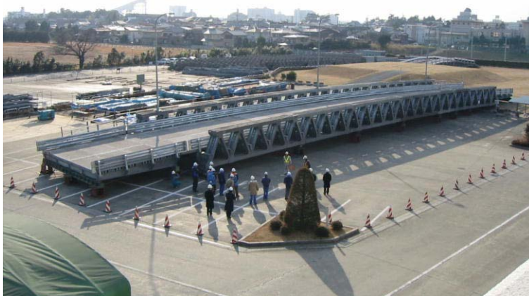
写真－ 3 応急組立橋架設状況
