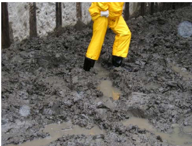
写真-2 含水比の高い掘削土
