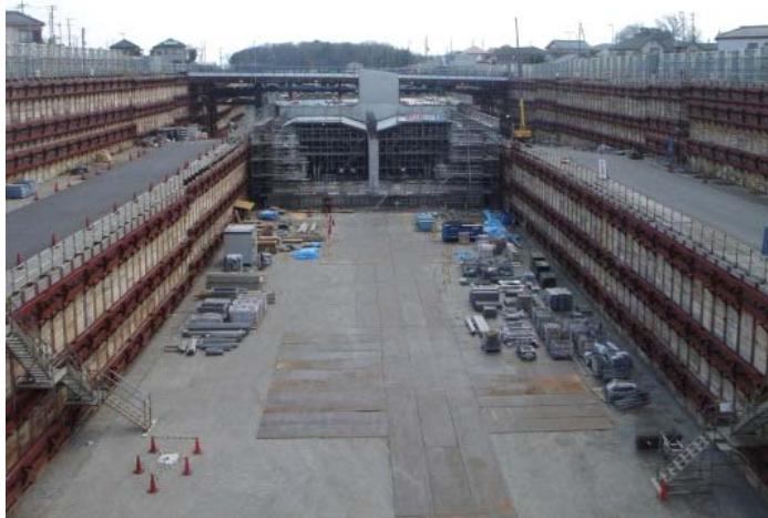
写真-1 躯体構築現場（松戸市下矢切地区）
