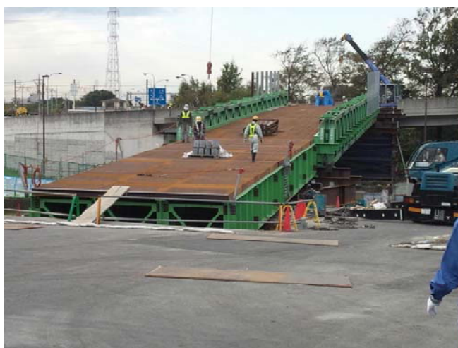
写真-5 工事用仮橋の設置状況
