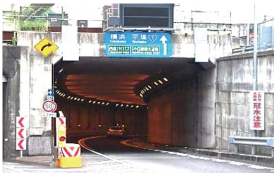
▲アンダーパス部の例【NO.112 箱根町山崎地先】
