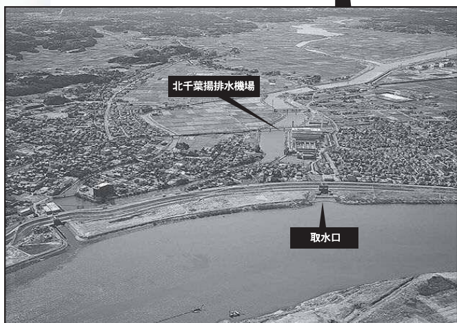
北千葉揚排水機場。手前が利根川。
