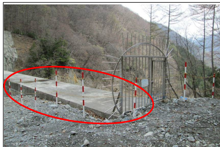
杭及びロープ再設置
