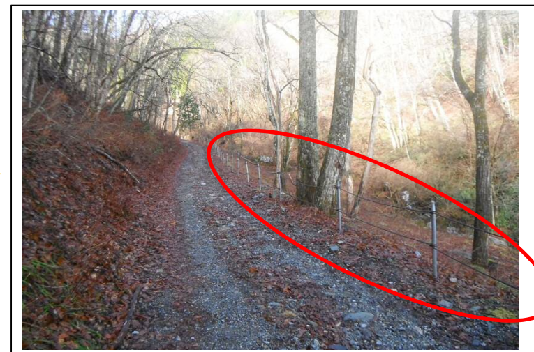
進入禁止柵の再設置
