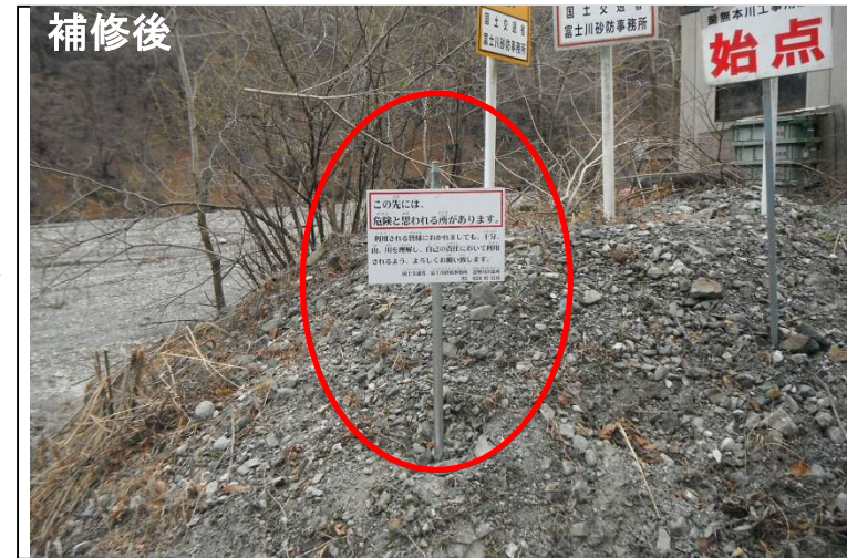
注意喚起看板の再設置
