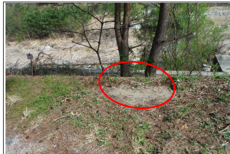
土砂による閉塞
