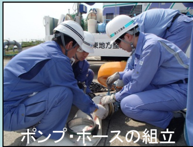
排水ポンプ車1台で 必要機材の運搬から排水運転まで可能
