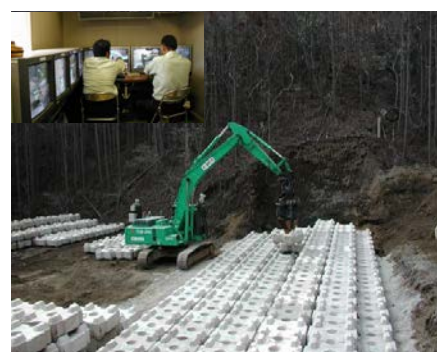
図 7 無人化施工の様子
