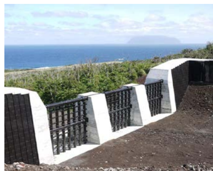
図9 厚木沢2号堰堤 (H24)
