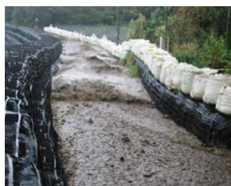
図 4 土のう積による嵩上
