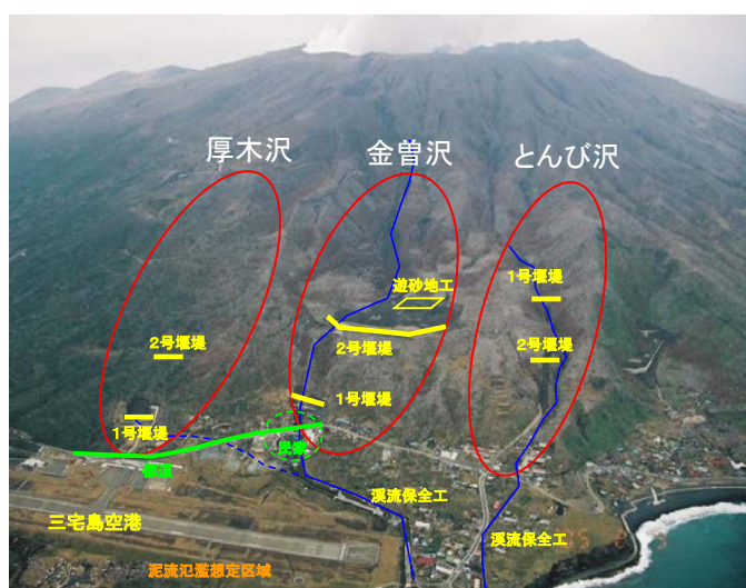
図10 厚木沢・金曾沢・とんび沢砂防事業の全景
