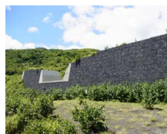
図 6 金曾沢 1 号堰堤（H13）
