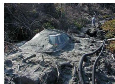
図3 泥流による被害
