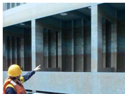
水門の保守・点検
