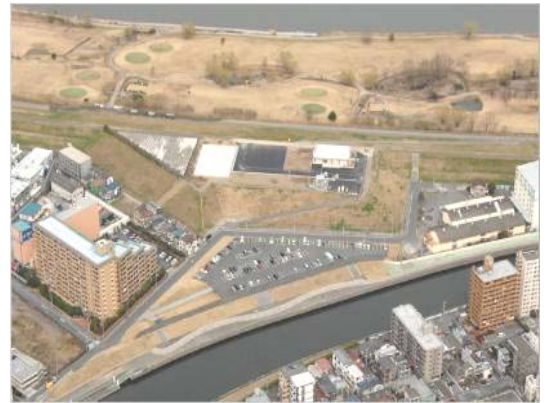
浮間地区荒川防災ステーション
