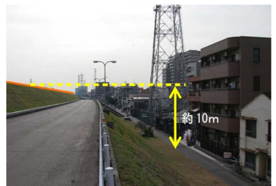
地盤沈下により低くなった市街地
