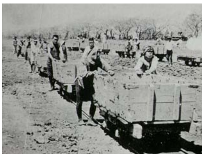
土砂運搬の様子
