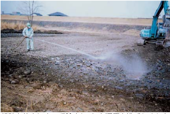
細砂を放水によって除去し、れき河原を造成しました
