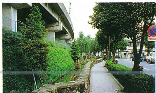
かつての農業用水を親水水路として復活し、街の中のオアシスとして活用しています。ここをたどれば荒川へ出られます。
