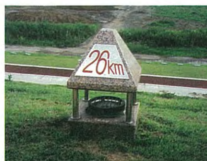
堤防天端に設置されている距離標識
