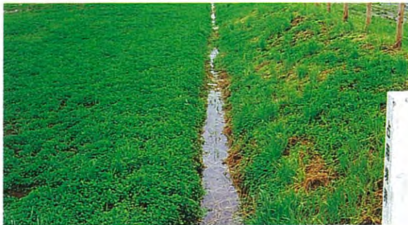
素堀りの水路。水路は、排水の機能とともに貯水機能を持たせます。
