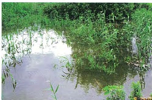
水路・池（三領水門上流、左岸）
