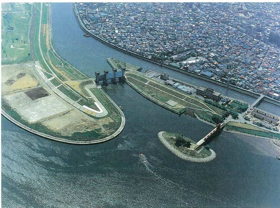
北区岩淵水門より下流を望む
