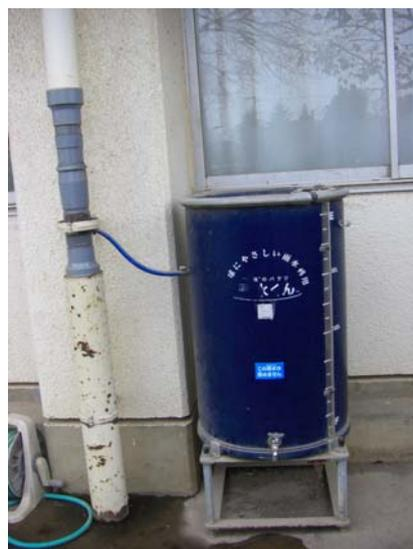
牛沼小学校(所沢市)に設置された雨水貯留槽
