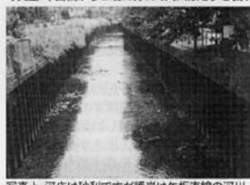
写真上：河床は砂利ですが護岸は矢板直線の河川
