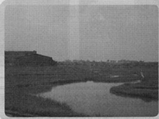
寺尾調節池全景
