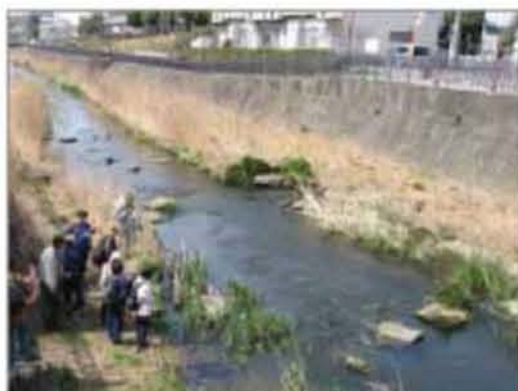
①都市整備区間では警察学校橋～水神橋までの低水路整備を見学しました。自然に見える低水路ですが、石の一つひとつにまで手が加えられているとのことでした。
