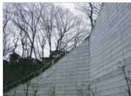
湧水地に建設されたマンション (開発により破壊された湧水)
