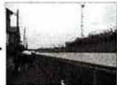
外山橋下流には分譲マンションが建設中です。
