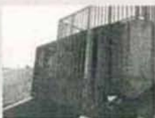
これが綾瀬川放流口です。
