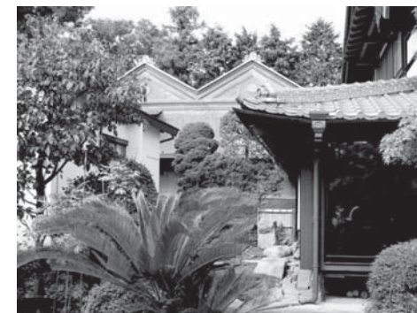
保全改修された「内倉」「外倉」とよばれる2棟の煉瓦製水塚と母屋(右側)
