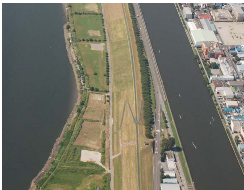
荒川運動公園付近の護岸（26.2km～27.0km 付近）
