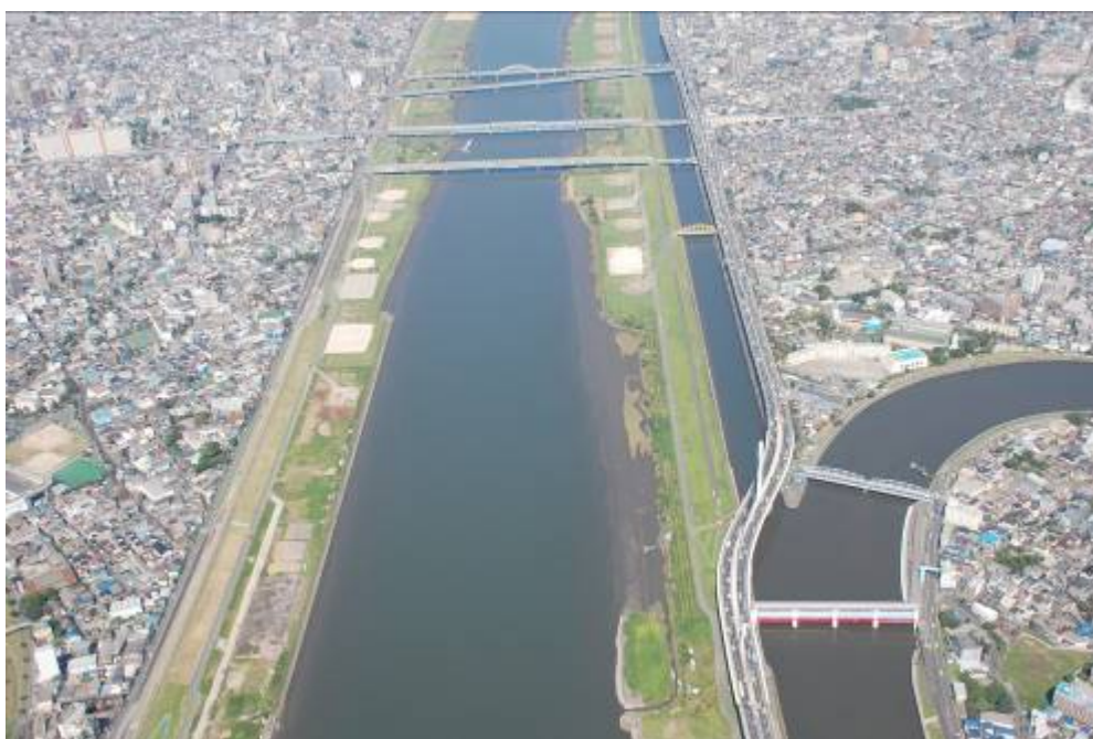
八広・東墨田ブロック付近の荒川（7.25km～9.0km）
