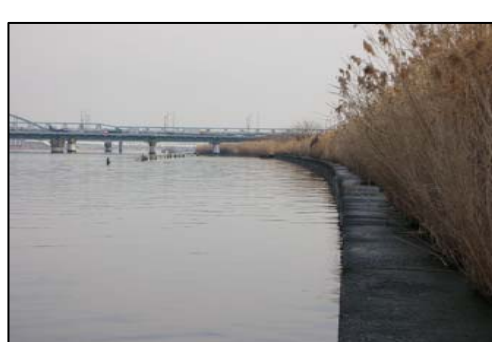
直壁護岸タイプ
