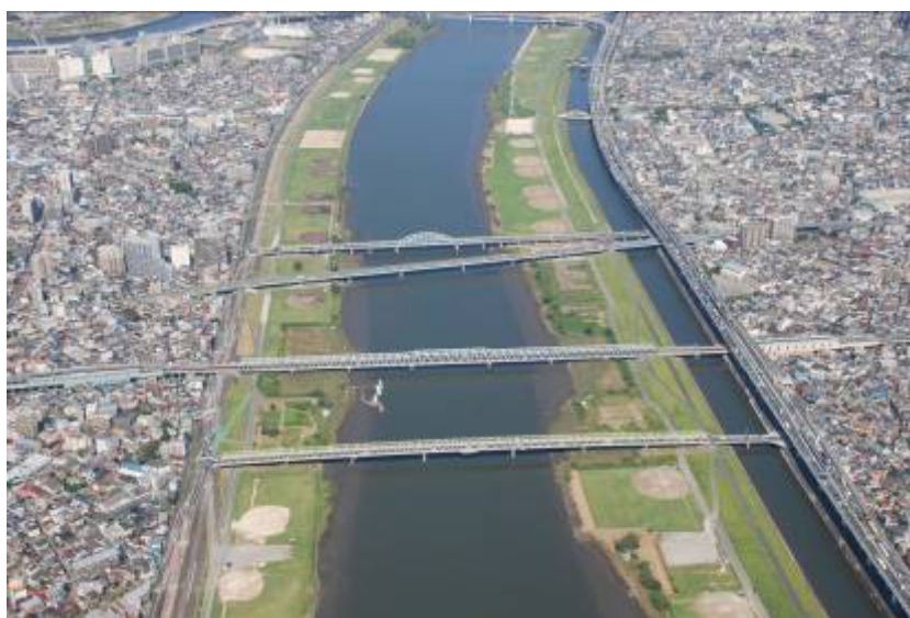
木根川橋～四つ木橋周辺の護岸（8.0km～10.0km）
