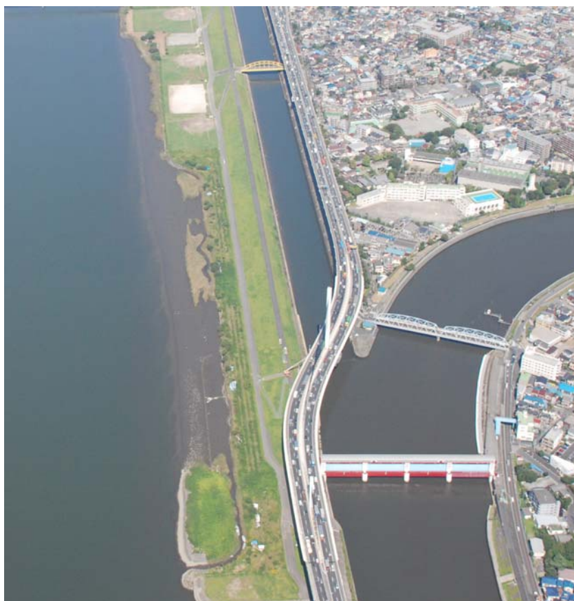
四つ木駅ブロックの護岸（6.75km～8.0km 付近）
