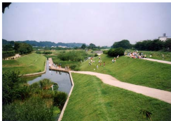
自然環境に配慮した金山調節池 金山調節池ワークショップ提供写真
