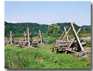
河川敷に設置された牛杵（水制）
