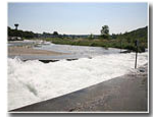
固定堰に設置された魚道
