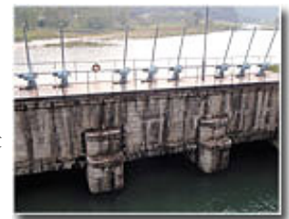
第一水門（コンクリート造）
