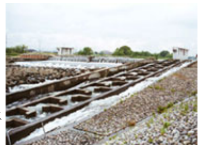
左岸側に設置された魚道
