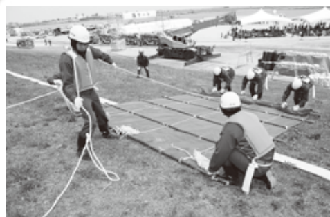
洪水流によって堤防の土が流されるのを防ぐ「シート張り工」
