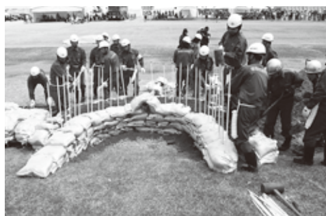
堤防から吹き出した水の勢いを弱め、土が流されるのを防ぐ「月の輪工」
