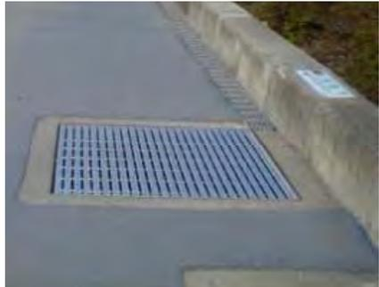
写真Ⅱ-2 グレーチング蓋の格子間隔を狭め、滑り止め加工している事例
