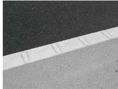
写真Ⅱ- 7 道路標示「車両通行帯」を凹凸のついた仕様とした事例
